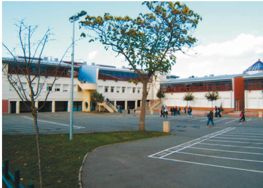
Cour : à gauche le collège rénové, à droite la construction neuve
