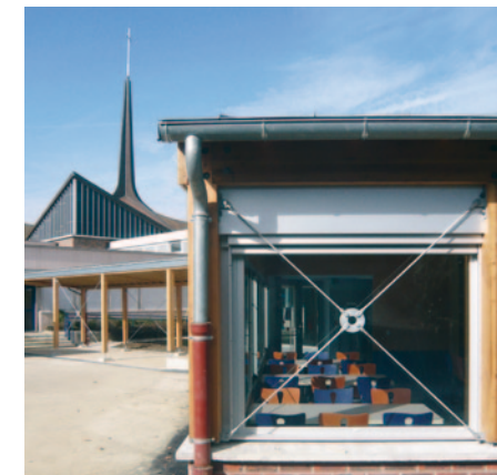
Extension vue depuis la cour
