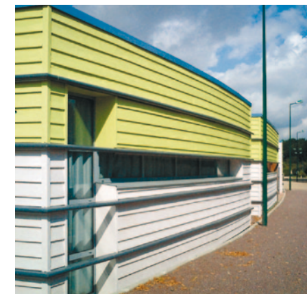
Détails de la façade
