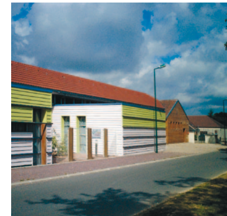
Salles de cours avec jardin patio
