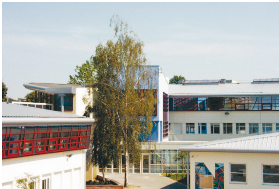
Le bâtiment de l'entrée a été diminué d'un étage
